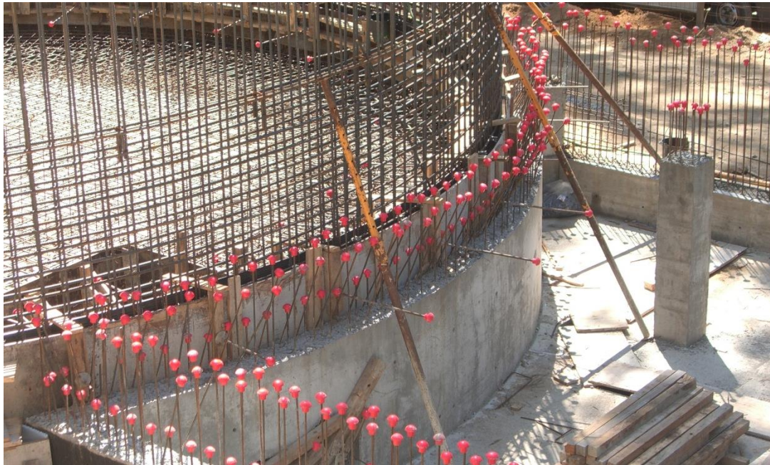
FIGURA 3: ACERO DE REFUERZO QUE SOBRESALE CON TAPAS DE PROTECCIÓN.
