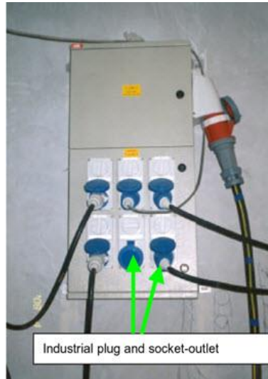
FIGURA 3: ESTÁNDAR INDUSTRIAL PARA CABLES, ENCHUFES Y TOMAS DE CORRIENTE
